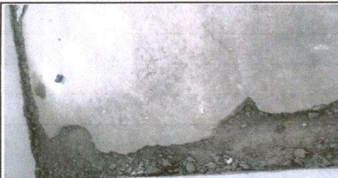
Foto 5: Sustitución de piso de torta de concreto por piso granito
