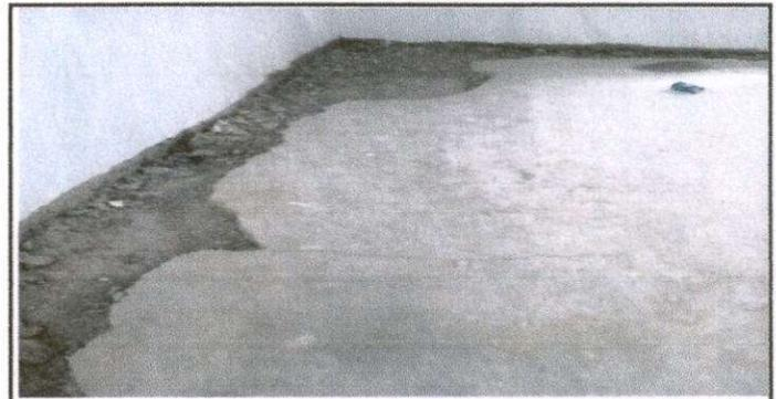
Foto 6: Sustitución de piso de torta de concreto por piso granito
